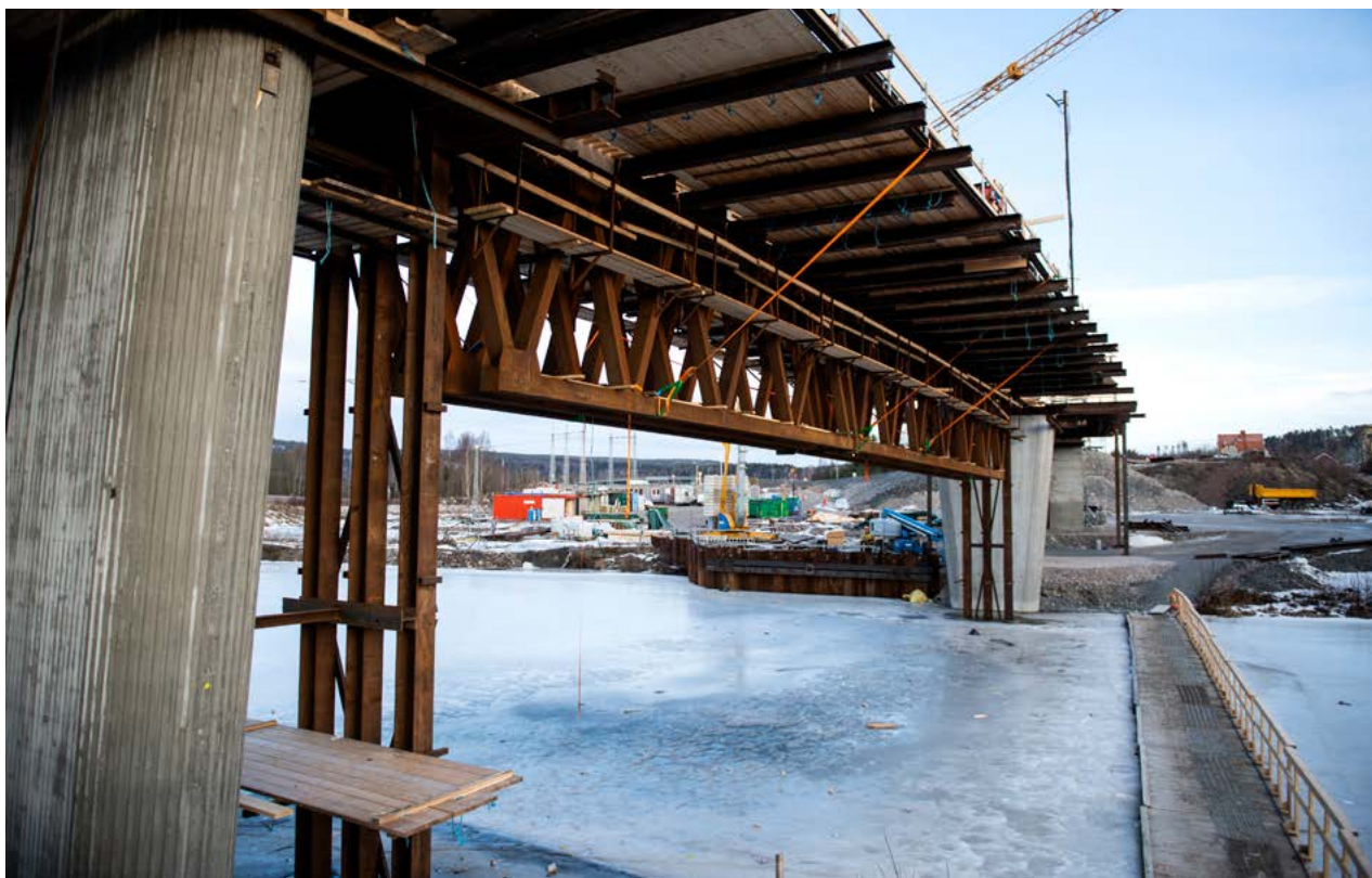
Gjutning av bro, Sundsvall.
